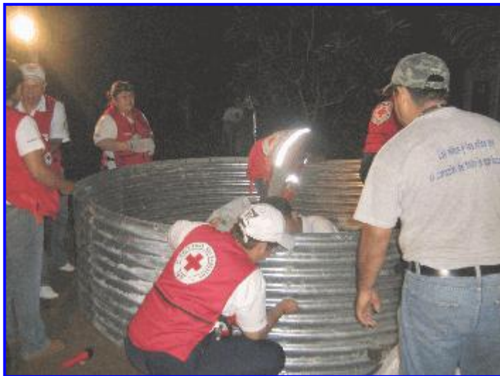
Instalación del tanque Oxfam en cantón Joya Grande, en Santiago Texacuangos, en San Salvador.
